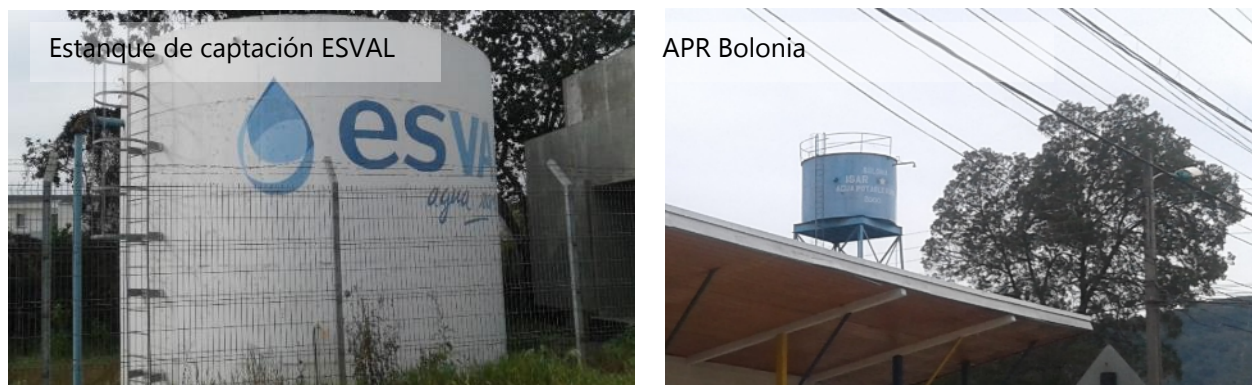
Figura 4-22 Imágenes sistemas de suministro de agua potable
