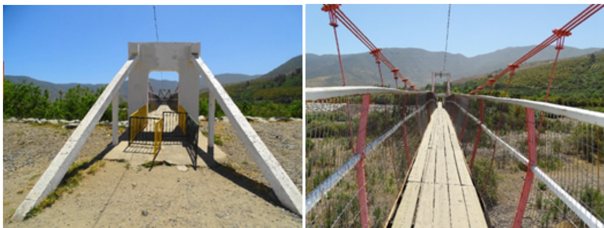
Figura 4-14 Imágenes Puente peatonal Lo Rojas
